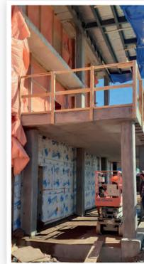
**En façade, la structure en porte-à-faux, qui servira de terrasse donnant sur l'aire de repas et qui abritera un abri de vélos au rez-de-chaussée, est bien installée.**
