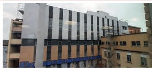
**La pose du parement extérieur aux étages supérieurs du mur est de l'aile D est très avancée, tandis que des travaux restent à faire aux étages inférieurs.**
