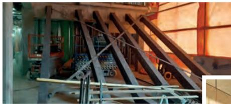
**Dans l'aire de repas, la structure porteuse des gradins est installée.**
