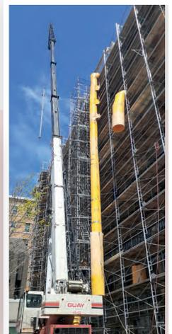
**Du côté ouest, la structure d'acier a été renforcée, les colombages métalliques et la laine s'installent graduellement.**
