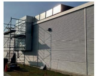
Conduite d'aération spécialement aménagée au début du chantier afin de préserver la qualité de l'air à l'intérieur du département de radio-oncologie (pavillon G).
