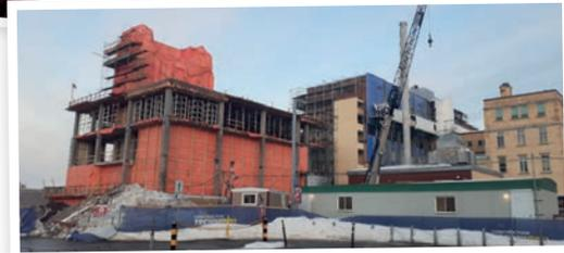
Le contour du bâtiment commence à être fermé. Le béton de la cage d'escalier et de l'ascenseur est coulé.
