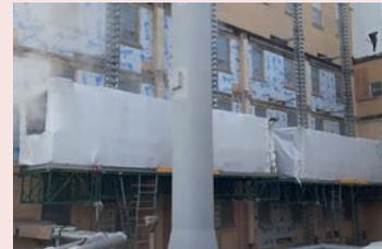
Toiles installées sur les parties mobiles des échafaudages du côté est afin de prévenir la dispersion de la poussière. Même si ces toiles n'ont pas été installées du côté ouest, l'entrepreneur est tenu de contrôler la poussière à la source (coupe à l'eau, équipement muni d'aspirateur, ventilateur).
